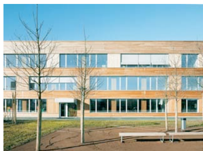
Schulhaus Eichmatt, Kanton Zug Einwohnergemeinden Cham und Hünenberg Architekten: Bünzli Courvoisier, Zürich
