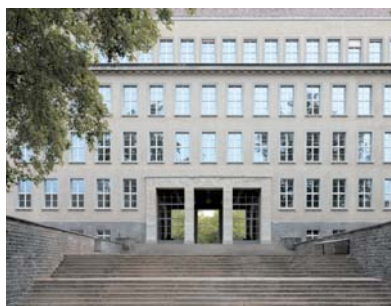
Sanierung Schulhaus Milchbuck, Zürich Amt für Hochbauten, Stadt Zürich Architekten: B.E.R.G. Architekten, Zürich
