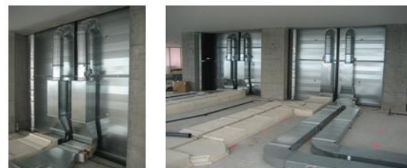
Einfaches Luftverteilkonzept, Grundausbau im Hohlboden, Mieterausbau an der Decke.
