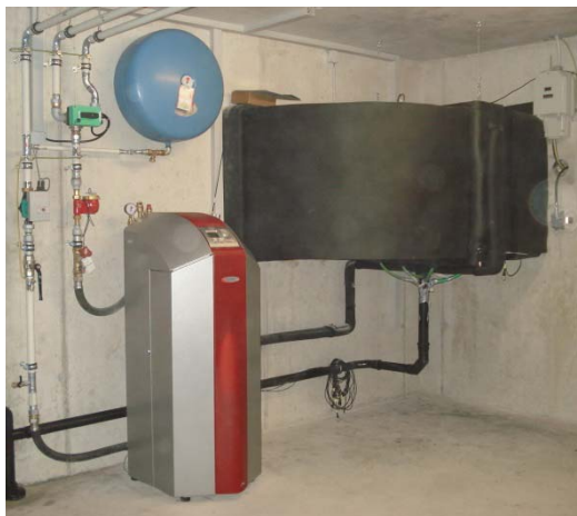
Leistungsgeregelte L/W-WP mit Luftkanal im Einfamilienhaus von Beat Wellig (links) und Prinzipschema des Heizsystems mit leistungsgeregelter L/W-WP und Frischwassersystem zur Brauchwarmwasseraufbereitung (rechts)
