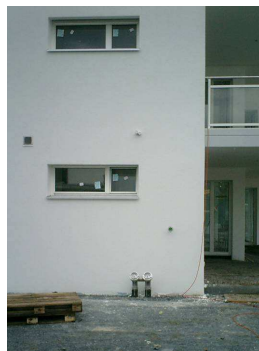
Füllstutzen im Aussenbereich
